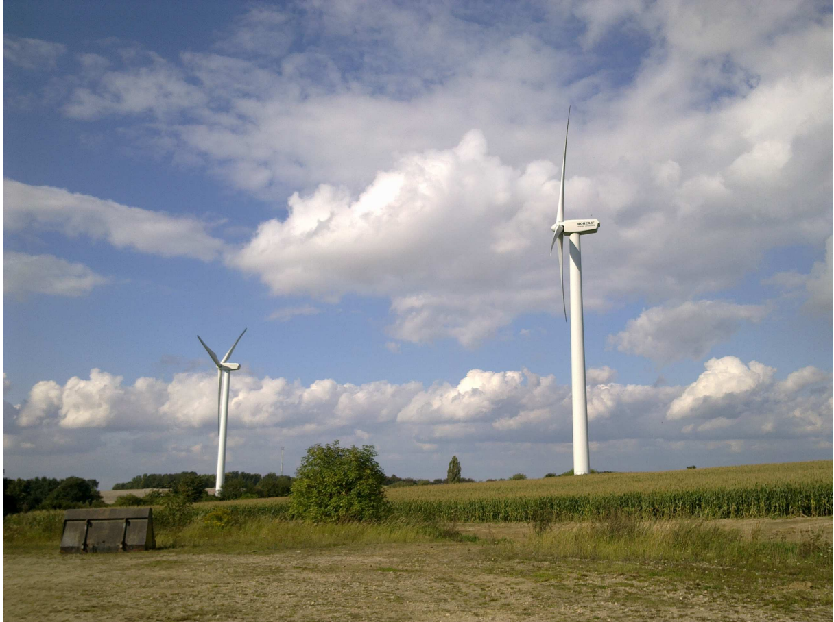
Abb. 3: Zwei Anlagen des Windparks „Butterberg“.
