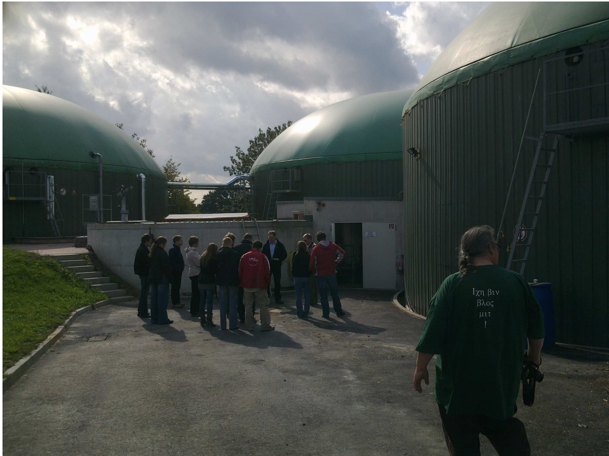
Abb. 2: An der Biogas-Anlage Grimma-Beiersdorf.
