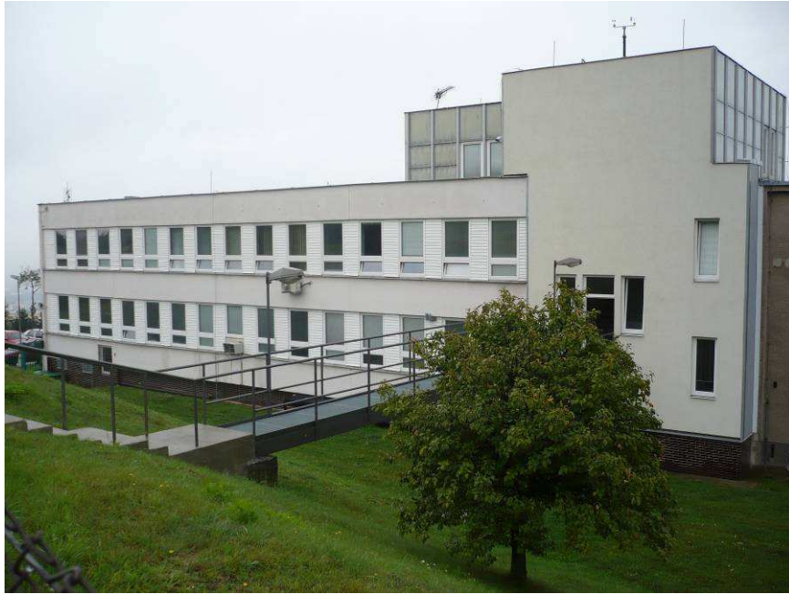
Abb. 1: Gebäude des CHMI Ústí nad Labem
